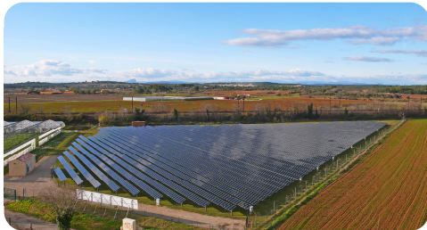
Centrale solaire de Lunel (34)
