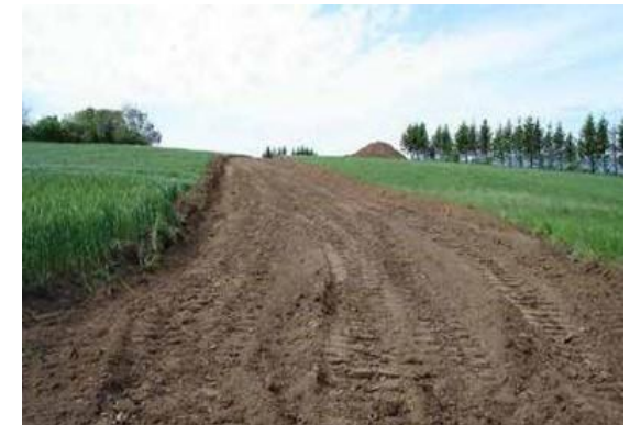
Mise en place du gravier
