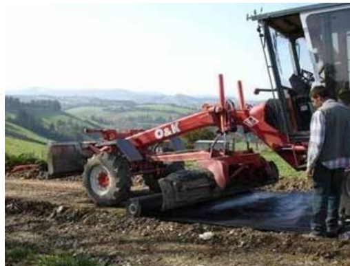
Pose du géotextile
