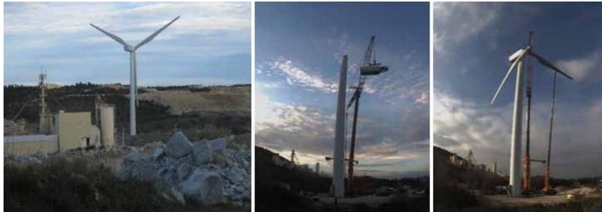
Eolienne de Centernach – Démantèlement de l'éolienne
