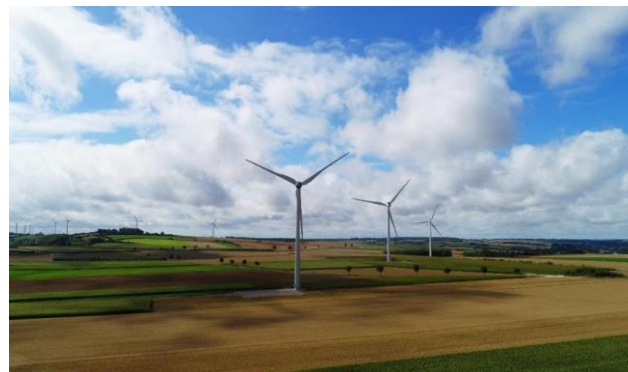
Parc éolien d'Audinctun (62) Mis en service en 2019
