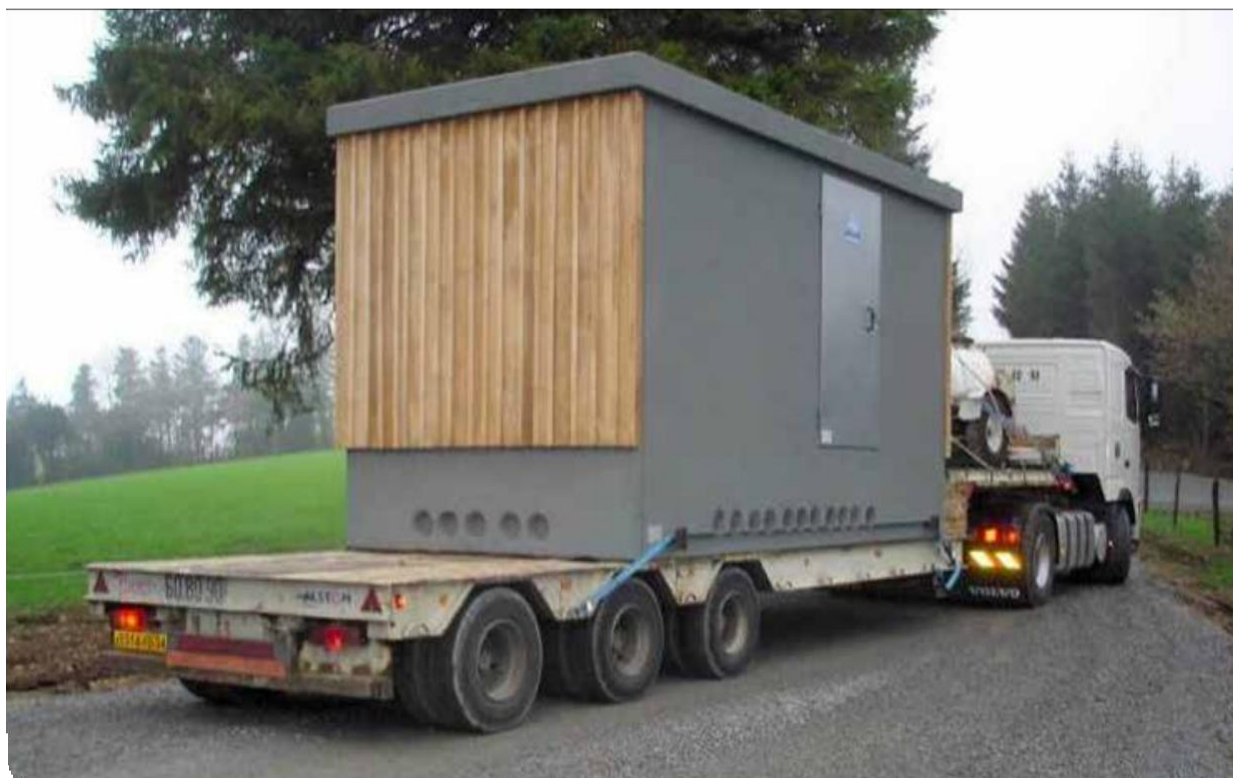
Arrivée d'un poste de livraison sur un site éolien
