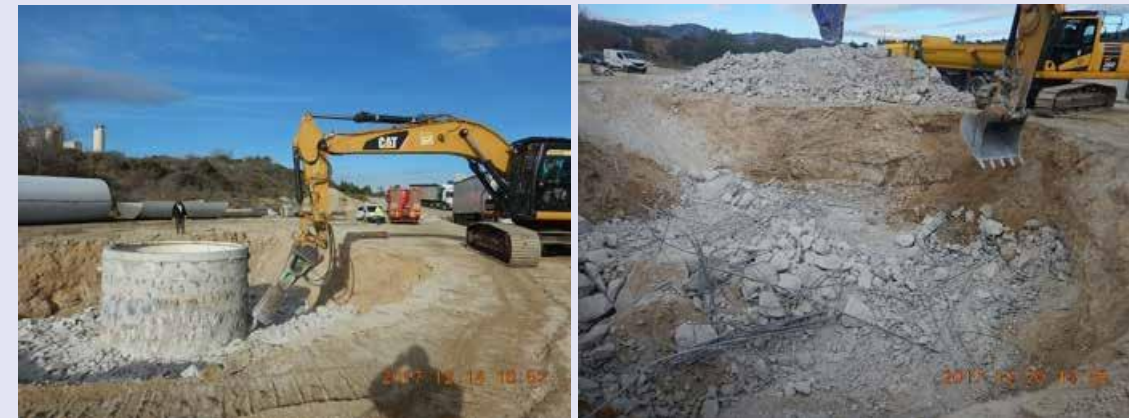
Destruction de la fondation
