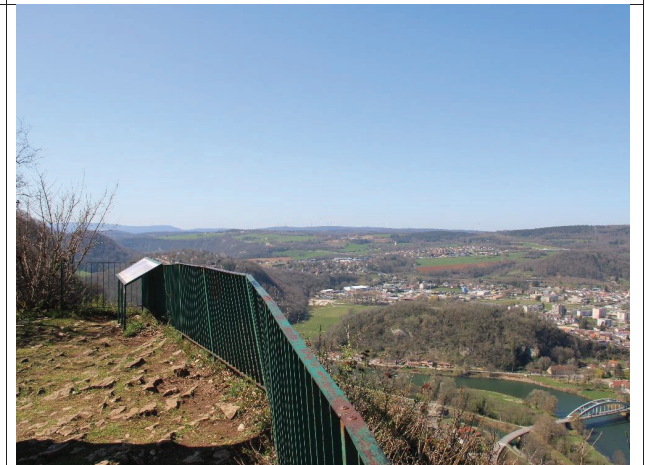
Figure 11 : Le belvédère de la Roche de Châtard - T&P 2020
