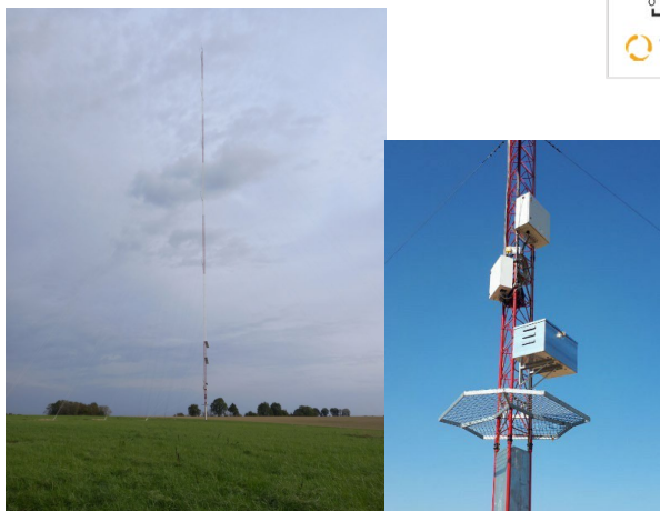
Mât de mesure de vent
