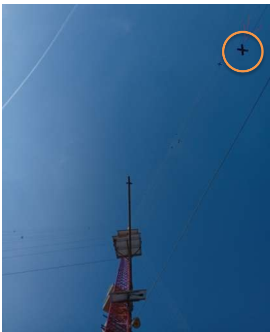
Photo du mât de mesure vue vers le haut depuis le pied à l'installation. On distingue les haubans, avec un croisillon de balisage anticollision (entouré en orange).
